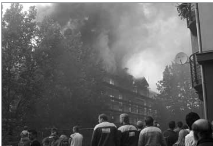
Požár rozestavěného bytového domu v polovině prázdnin způsobil, že se do něj nájemníci budou moci nastěhovat až o tři čtvrtě roku později.
