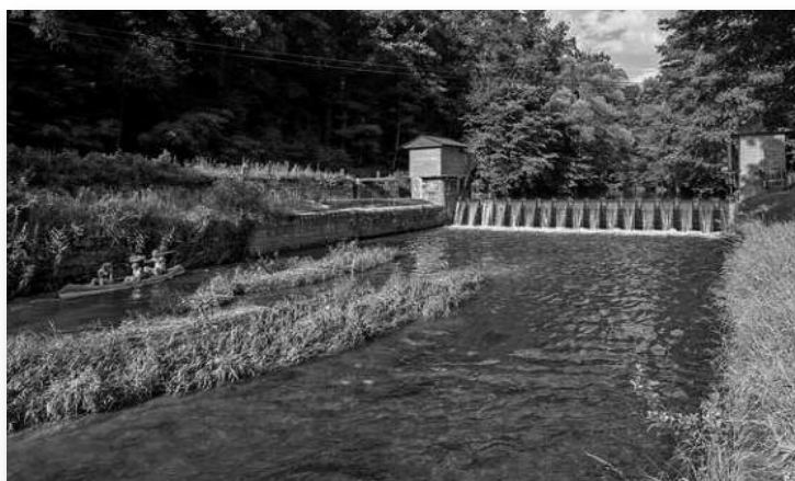
Po povodních v roce 2010 byl starý stavidlový jez na Nise u Dolní Suché nahrazen novým automatizovaným zařízením.
